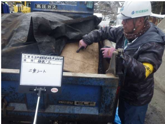
アスファルト合材運搬時の保温
