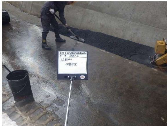
手作業によるアスファルト舗装
