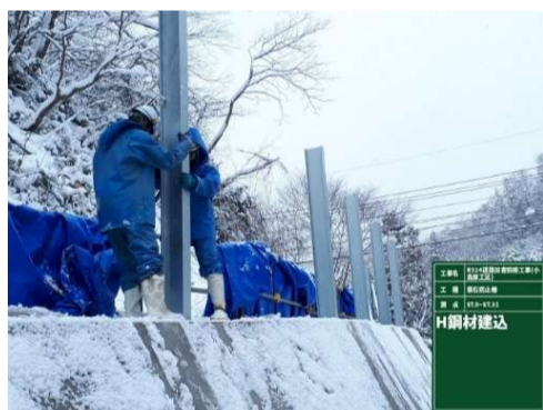
支柱建込（落石防止柵）
