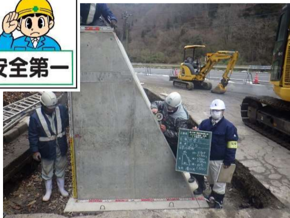
擁壁施工状況（落石防止柵）
