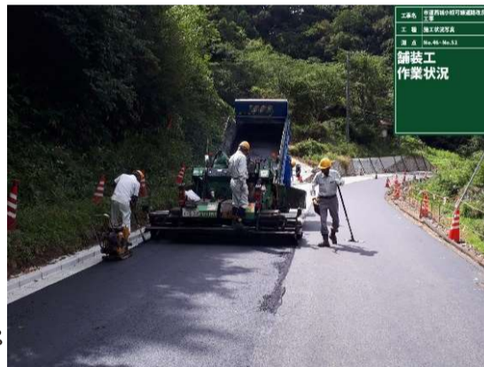
As舗装敷均し
