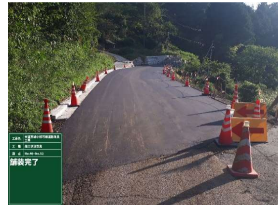
As舗装完成
