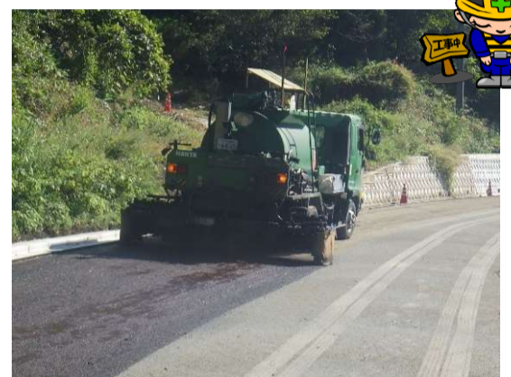
舗装前乳剤散布
