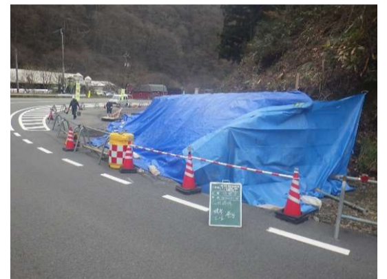
打設完了シート養生
