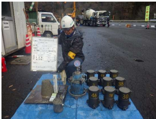
コンクリート試験
