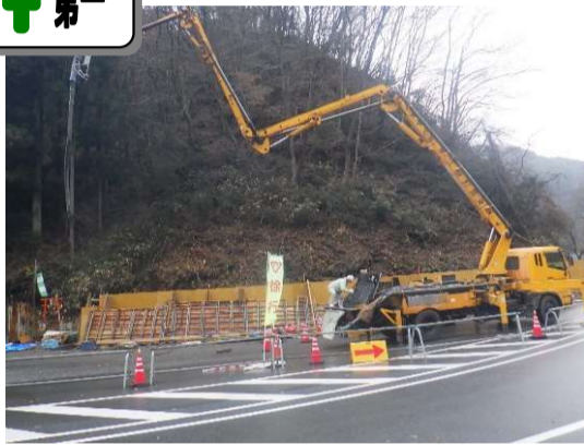
ポンプでのコンクリート圧送
