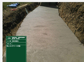
待受式擁壁工
