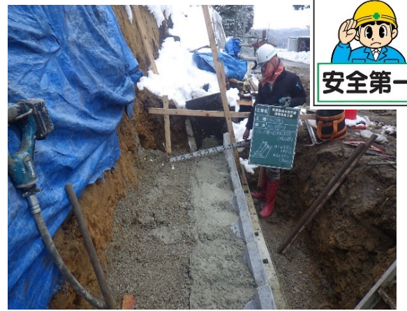
ブロック積施工状況
