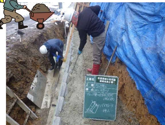
ブロック積施工状況
