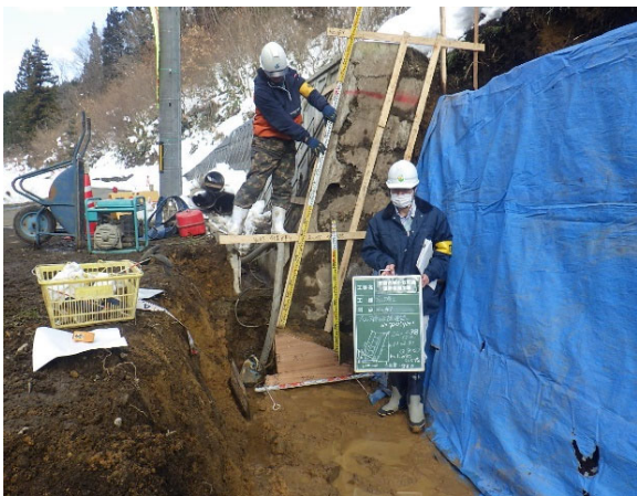
市監督員床掘立会確認
