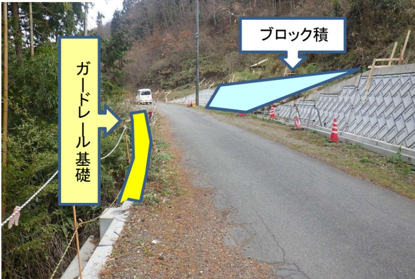
右側にブロック積、左側にガードレール基礎を施工します。
