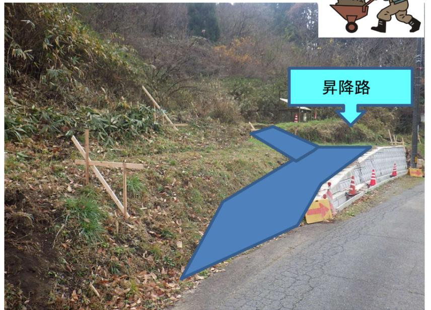
右側ブロック積の最後に昇降路を設置します。
