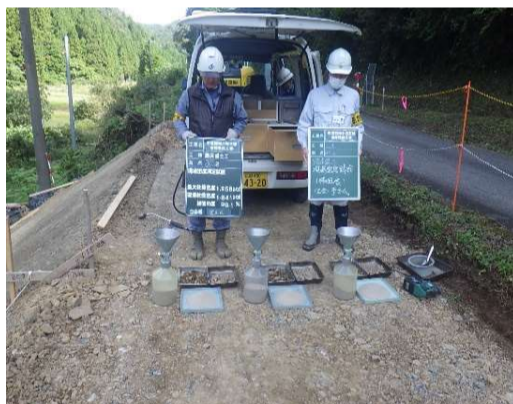
土の締固めの確認立会
