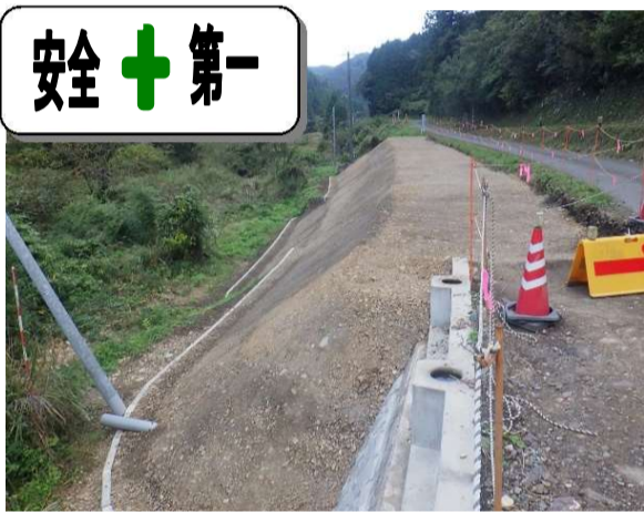
盛土完了(No.50付近)
