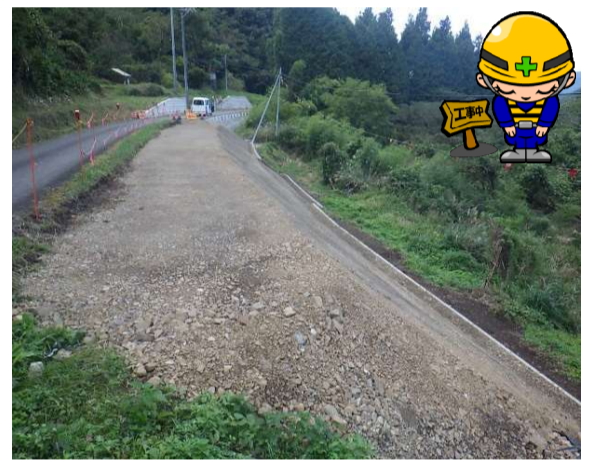
盛土完了(No.52付近)
