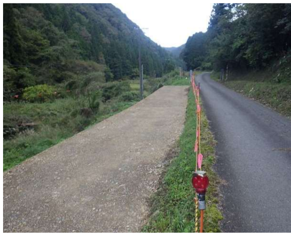
盛土完了(No.51付近)
