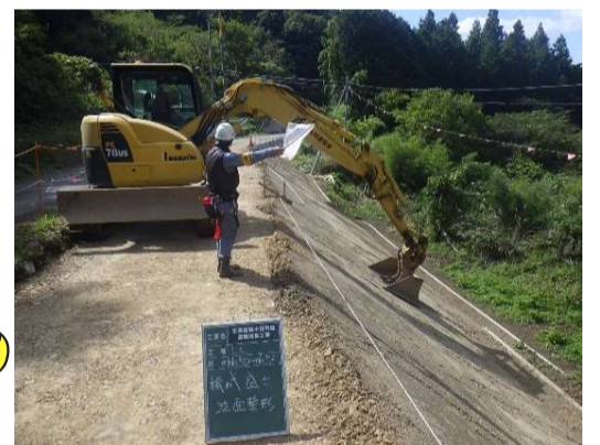
盛土法面整形
