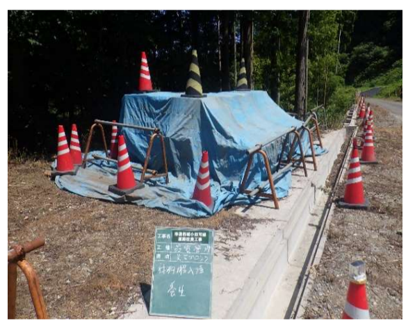
ブロック積完成
