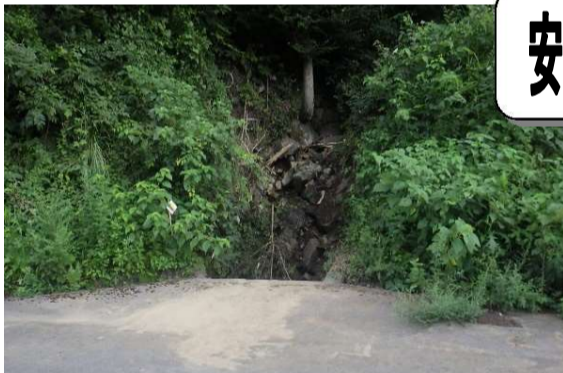
椀谷川手前の倒木処理
