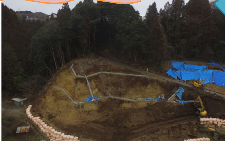
荻野B地区 急傾斜地崩壊対策工事 【現在の状況】
